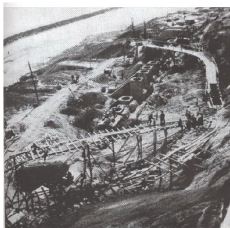
Fig. 20 – Imagine de la lucrările la faleza nord-estică 1956-1957.
