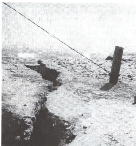
Fig. 9 – Fază activă a prăbușirii falezei.
