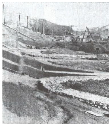
Fig. 16 – Imagine din timpul execuție arcelor de descărcare (faleza sudică).
