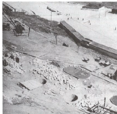
Fig. 22 – Imagine din timpul execuției puțurilor de drenaj (faleza nord-estică)
